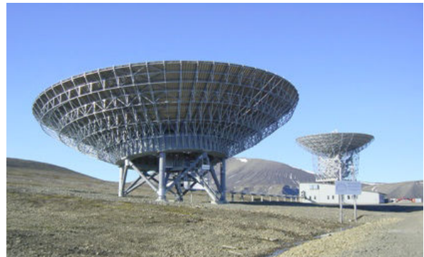
EISCAT Svalbard radar antennas.
